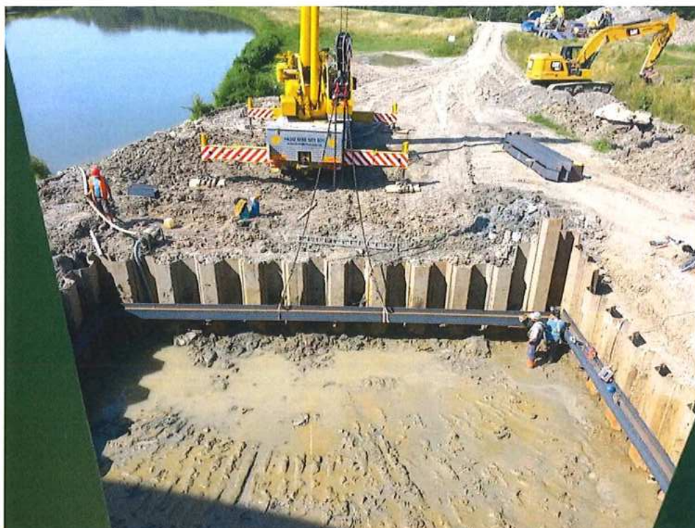
Zemné práce a rozperný rám na CZ strane - základ č.2 – SO 12-33-04
