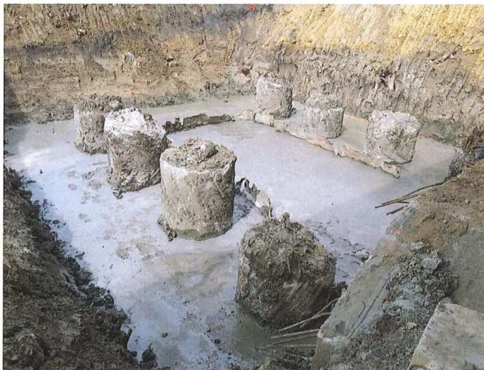
Odkop hláv pilót na CZ strane - opora 2 + podkladný betón– SO 12-33-04
