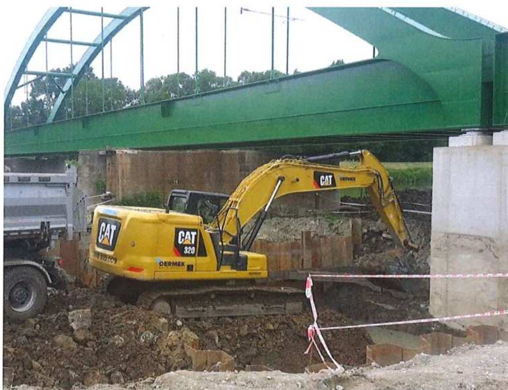
Zemné práce a rozperný rám na SK strane - základ č.1 – SO 12-33-04
