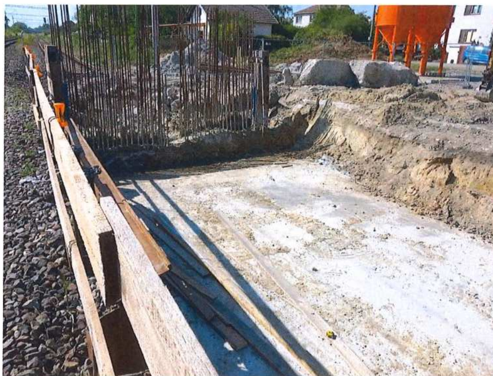
Odbúranie vodiach múrikov a príprava na armovanie stropnej dosky – SO 11-33-04
