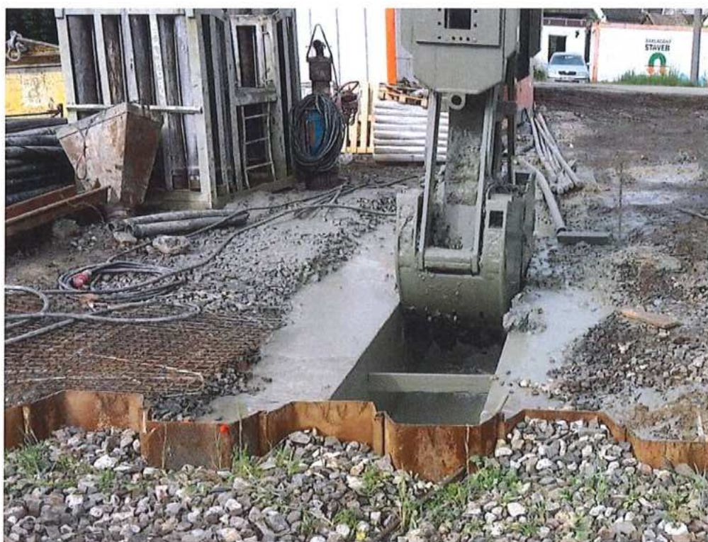
Realizácia podzemných stien – SO 11-33-04
