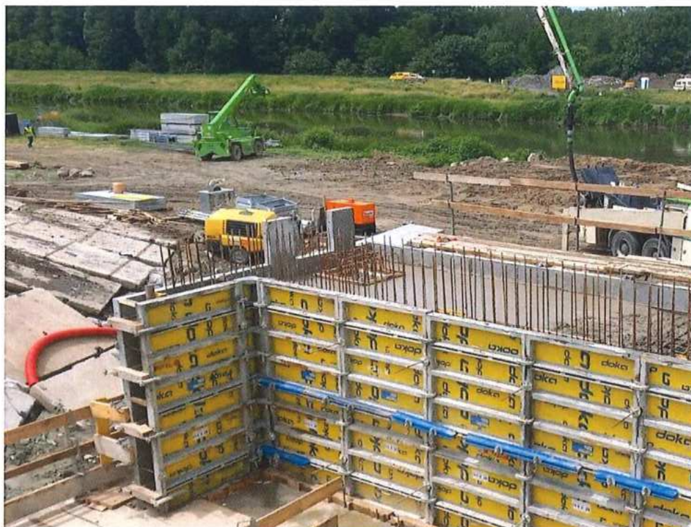
Betonáž dříeku - opora č.1 – SO 12-33-04
